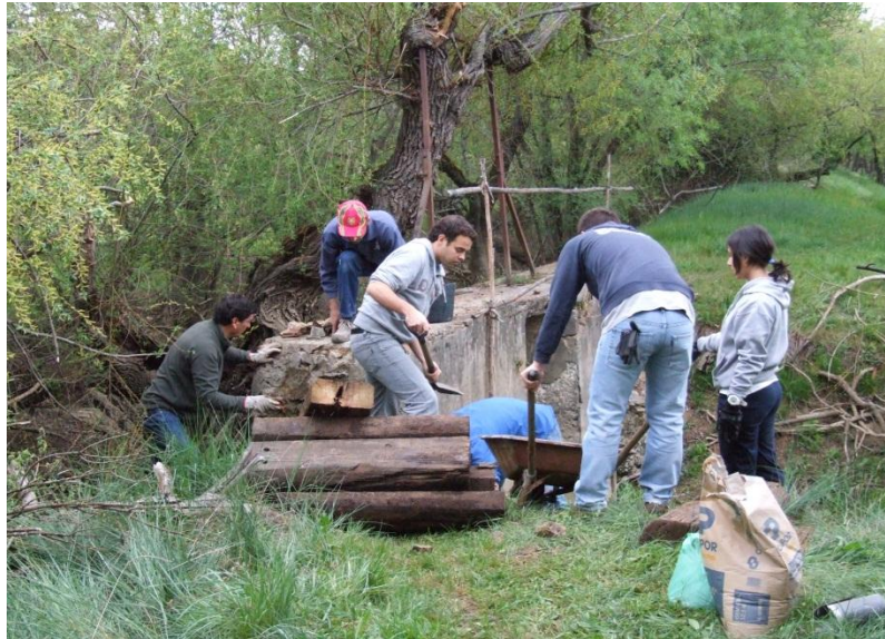
Figura 1. 2- Construção e restauração de umas escadas e ponte
