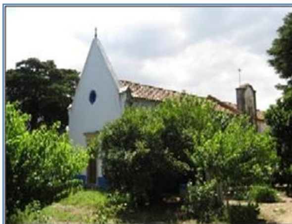
Figura 7: Capela existente na Quinta do Paul do Boquilobo (Instituto de Conservação da Natureza e Biodiversidade, 2011)
