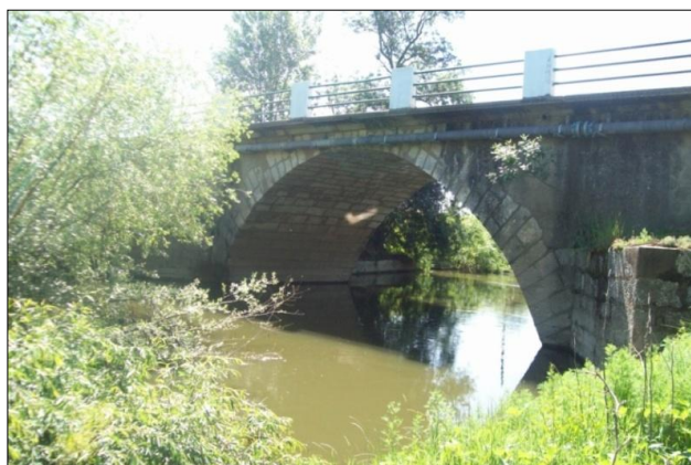
Figura 51: Ponto 4 – Ponte da Broa.
